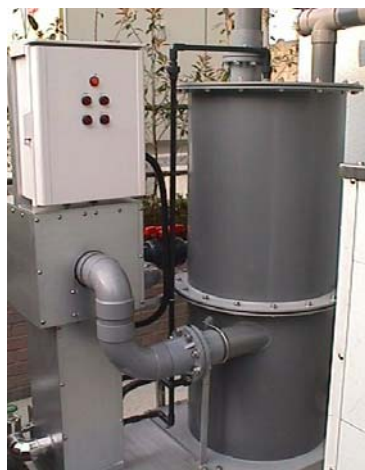
充填式微生物脱臭装置(小型)
