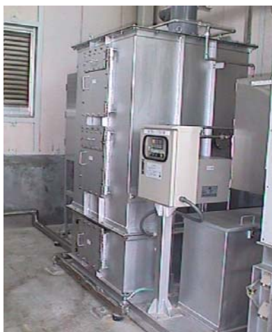
充填式微生物脱臭装置(大型)
