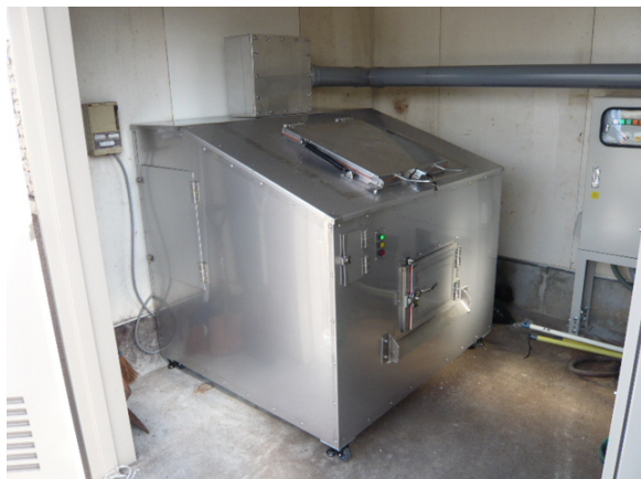
■1 槽式 80kg 処理／日(平成 22 年 1 月導入)
